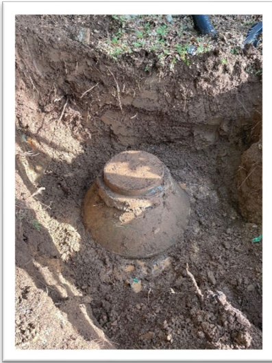
Black Rd – Old style cleanout vs. new mini manhole.
