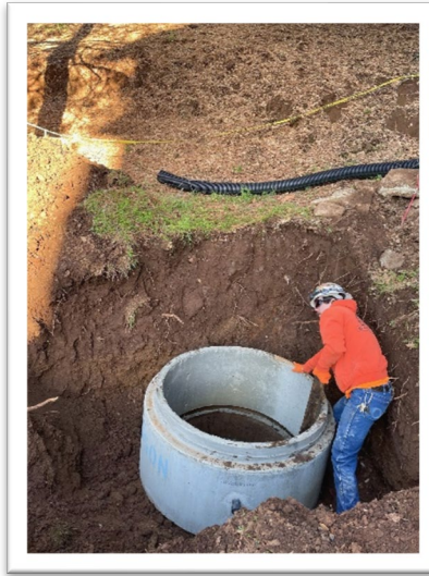
Black Rd – Old style cleanout vs. new mini manhole.
