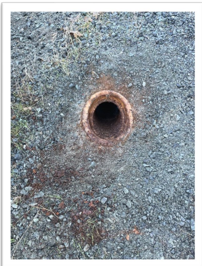
Black Rd – Old style cleanout vs. new mini manhole.
